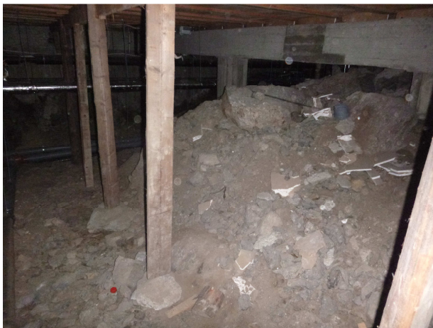
Bild 3. Exempel på trästöttor mot marken och byggsplill på marken.
