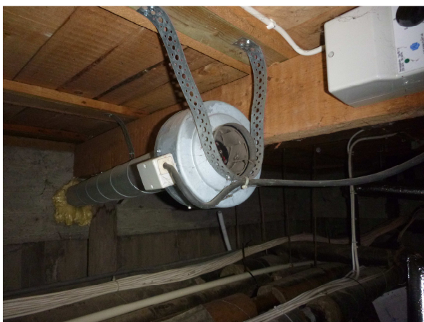
Bild 5. Exempel på undertryckventilation av grund.
