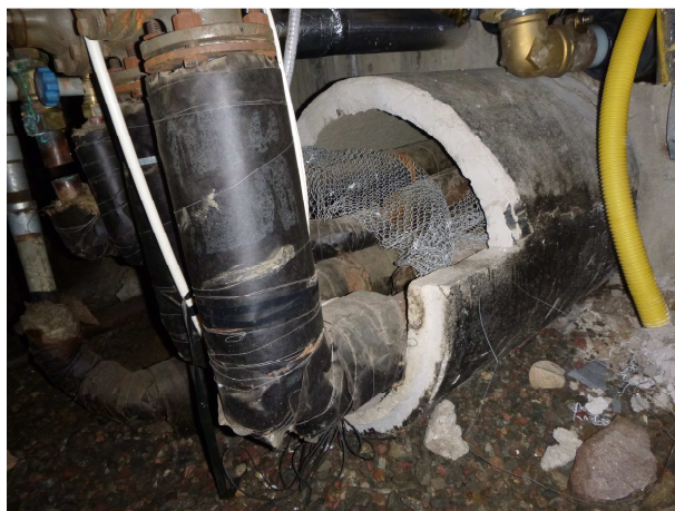
Bild 10. Exempel på äldre rörschakt som är öppna.
