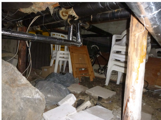
Bild 9. Krypgrunden används lokalt som förråd.
