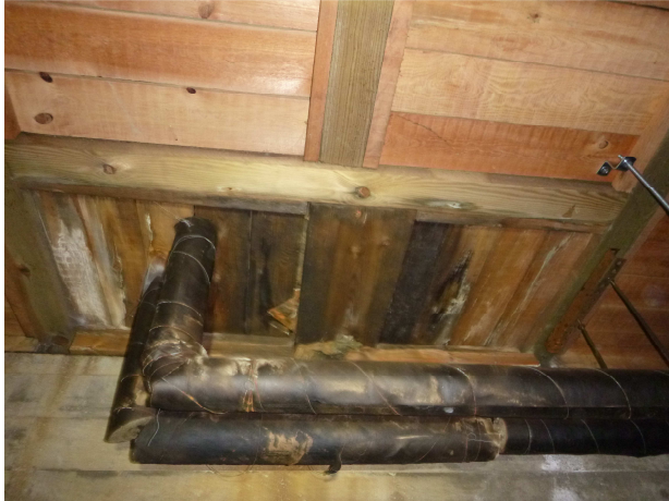
Bild 1. Fuktfläck (FK 19 %) i bjälklag under gatunummer 92.
