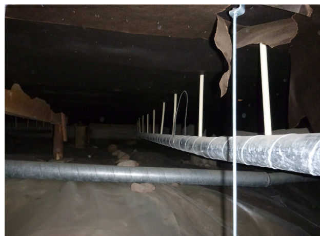
Bild 6. Exempel undertrycksventilation av bjälklag.
